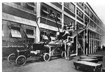
Kompletace Fordu T – dosazení karoserie na podvozek s motorem
